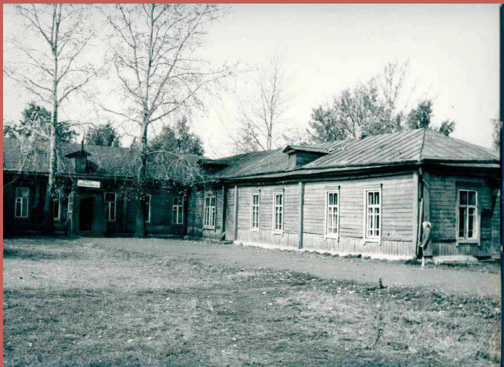
Одноэтажное здание школы (бывший райисполком)
